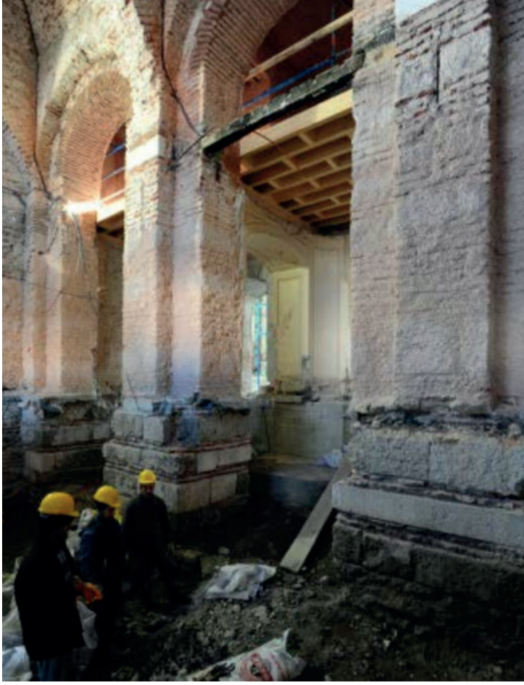
Resim 5. Büyük Mecidiye Cami zemindeki betonarme döşemenin tahliyesi (Ersen ve Timas Koçak, 2014)
