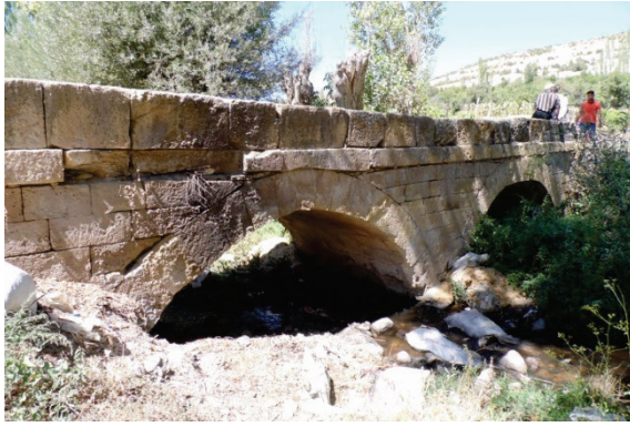
Fotoğraf 40: Yeşildere Hacı Meryem Köprüsü Mansap Görünüşü
