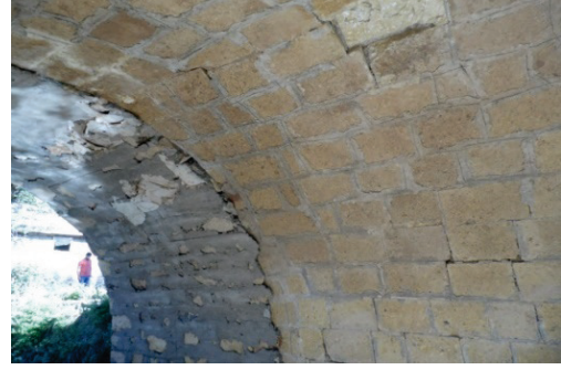
Fotoğraf 43: Güneydere Ilıcak Köprüsü Kemer Karnından Görünüş
