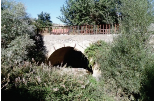
Fotoğraf 42: Güneydere Ilıcak Köprüsü Genel Görünüş
