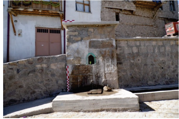
Fotoğraf 22: Güneydere Kör Çeşme Cephe Görünüşü
