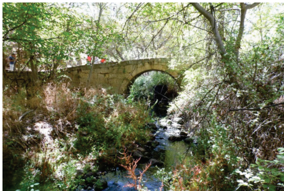
Fotoğraf 38: Yeşildere Karadoğan Köprüsü Mamba Cephesi
