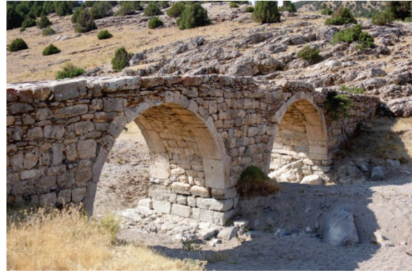
Fotoğraf 35: Gökyurt Çileder Köprüsü Mansap Görünüşü
