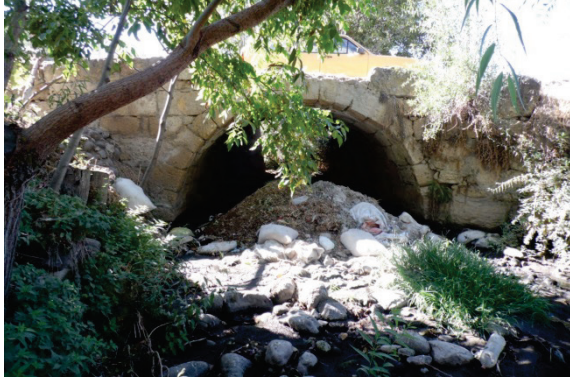
Fotoğraf 36: Yeşildere Köprüsü Mansap Cephesi
