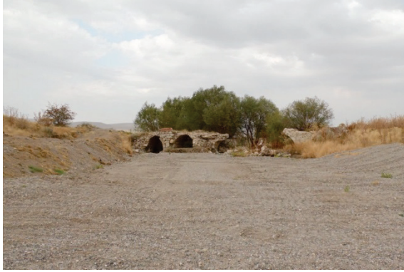
Fotoğraf 28: Hatunsaray Gömse Köprüsü Genel Görünüş
