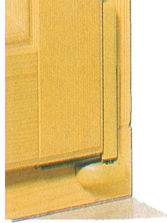
Şekil 14. Lamine ahşap kirişin kapılarda kayıt olarak kullanılması
