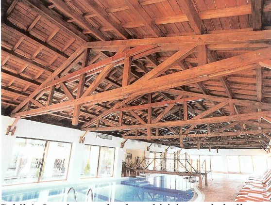
Şekil 1. Laminasyonlu ahşap kirişin çatıda kullanımı
