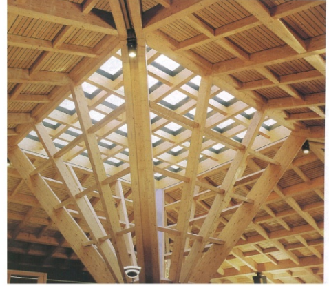
Şekil 2. Laminasyonlu ahşap kirişlerle yapılan çatı
