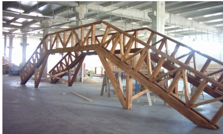
Şekil 8. Köprünün tamamlanmış hali
