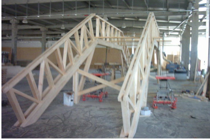
Şekil 7. Köprünün yapılış aşamasında
