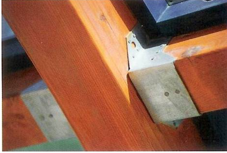
Şekil 16. Laminasyonlu ahşap kiriş ile aşıklık bağlantısı
