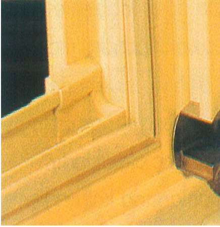
Şekil 11. Lamine ahşap kirişin pencere kasasında kullanımı
