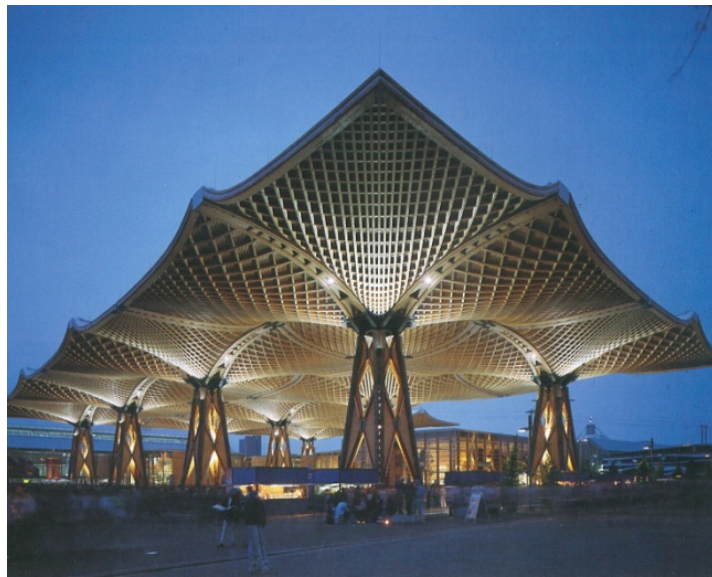
Şekil 5. Laminasyonlu ahşap kirişlerle yapılmış fuar alanı
