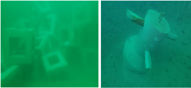
Şekil 2. Yapay resif kümeleri ve Anti trol yapay resif bloğunun sualtı görüntüsü (Foto: B. Gül). Figure 2. Underwater view of artificial reef sets and anti-trawler units (Photo B. Gül).
