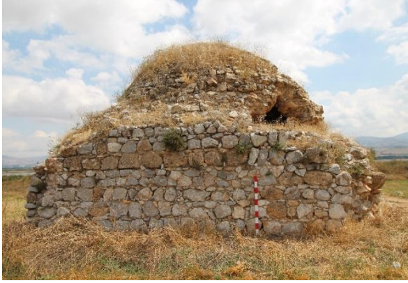
Fotoğraf 5 Batı cephe
