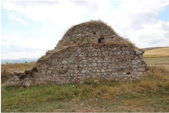
Fotoğraf 3 Kuzey cephe
