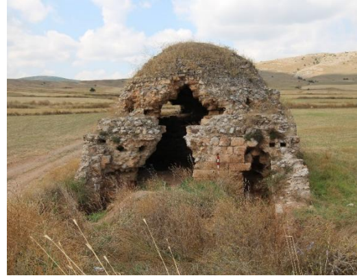
Fotoğraf 6 Doğu-Giriş Cephesi
