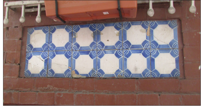
Fotoğraf 8. 17 Pafta, 304 Ada, 14 Parsel Sivil Mimarlık Örneği çinilerinden detay (Şennur Kaya, 2015) / Tiles of Civil Architecture Example in 17 Layout, 304 Block, 14 Parcel.
