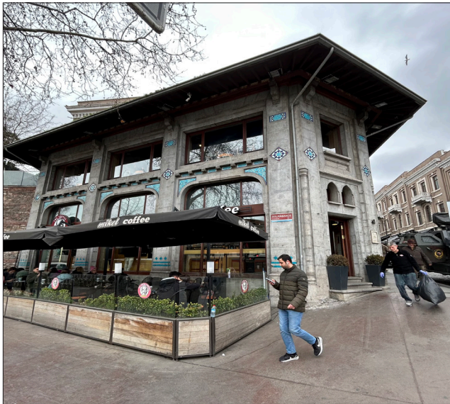
Fotoğraf 19. 73 Pafta, 723 Ada, 1 Parsel Milli Emlak Dükkanları (Hatice Adıgüzel, 2023) / National Real Estate Shops in 73 Layout, 723 Block, 1 Parcel.
