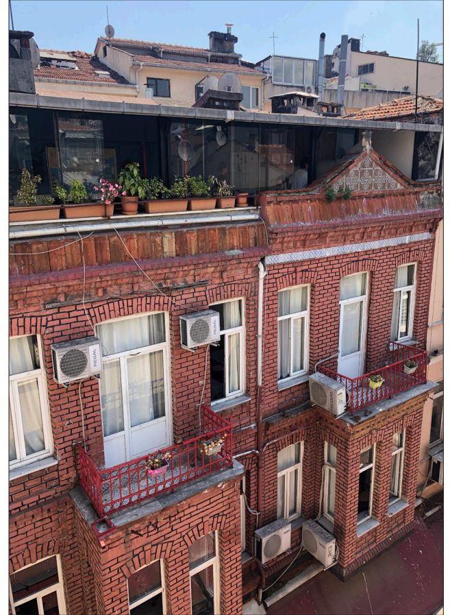
Fotoğraf 1. 16 Pafta, 283 Ada, 81 Parsel / Sivil Mimarlık Örneği (Hatice Adıgüzel, 2022) / Civil Architecture Examle in 16 Layout, 283 Block, 81 Parcel.
