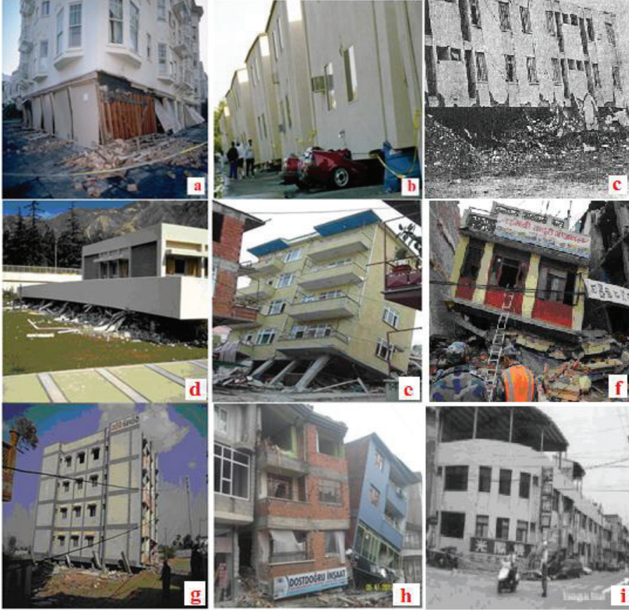
Şekil 1. Yumuşak kat hasarları a- Loma Prietta depremi b- Oakland depremi, c- Cezayir depremi d- Kaloiforniya depremi, e- İzmit depremi, f- Nepal depremi, g- Hindistan depremi, h- Van depremi, i- Tayvan depremi.
