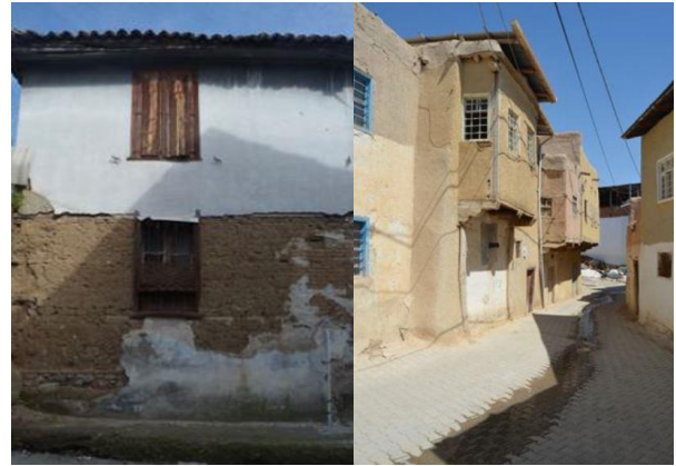
(a) (b) Şekil 10. Balıkesir/Havran (a) ve Malatya/Balaban (b)’da kerpiç yapı örnekleri, 2016
