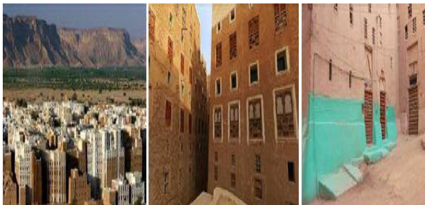
Şekil 9. Şibam’da çok katlı kerpiç yapılar [32]
