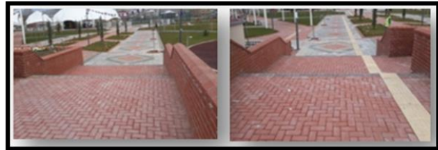
Şekil 3. Kılavuz Çizgili Giriş Merdiveni
