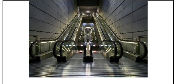
Şekil 4. Danimarka'nın başkenti Kopenhag'da Amagerbro metro istasyonunda yer alan yürüyen merdivenler (İnternet 5)
