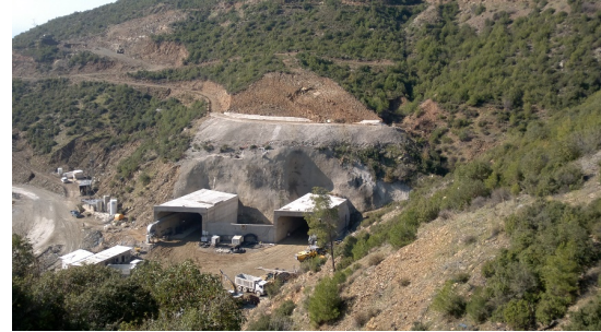
Şekil 3. Tüneli giriş portal kesim (Mersin – Anamur Yönü)
