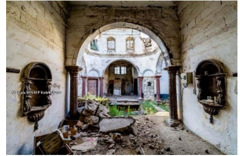
Şekil 18: Kubbe Yıkıldıktan sonraki durum (Şenalp, M., 2022c)
