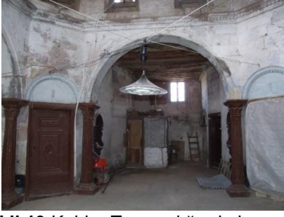
Şekil 19 Kubbe Taşıyıcılığında kemerler (Tavacıgil, 2007c)
