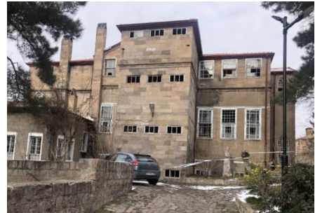
Şekil 44: Yapının güney cephesi (Parlak Biçer, Akdağ, 2020 s. 322-346)
