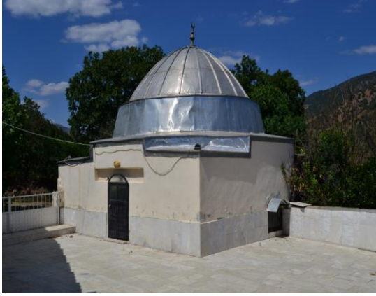
Fotoğraf 1: Kasım Bey Türbesi'nin dış görünüşü.
