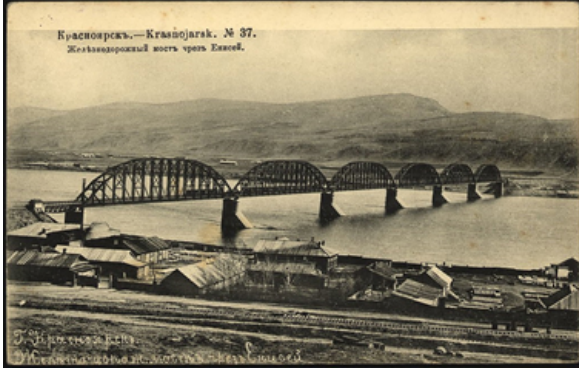
Fotoğraf: Krasnoyarsk yakınlarında Yenisey Nehri üzerindeki ilk demiryolu köprüsü. 1895-1899 yılında inşa edilen köprü 2007'ye kadar hizmet vermiştir. ( https://www.vokrugsveta.ru/vs/article/387/ ).
