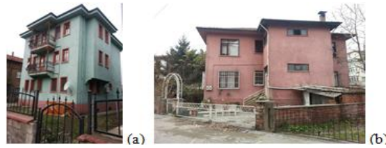
Şekil 4. Araştırma alanlarında bulunan betonarme yapılardan örnekler: (a) Kemal Samancıoğlu Sokak, (b) Turna Sokak.
