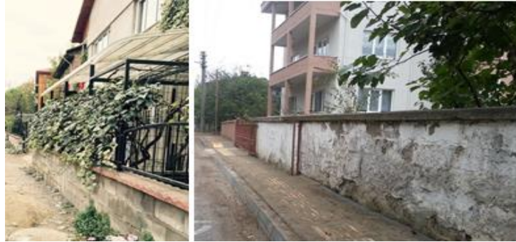
Şekil 9. Araştırma alanlarındaki bahçe duvarlarına ilişkin örnekler.
