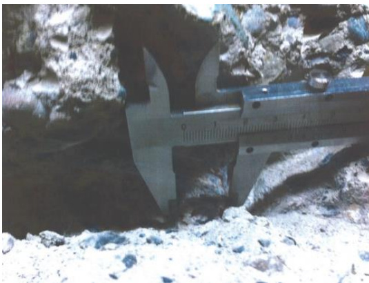
Şekil 7. Donatı tespiti, onarım-2
