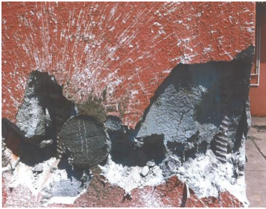
Şekil 6. Donatı tespiti, onarım-1
