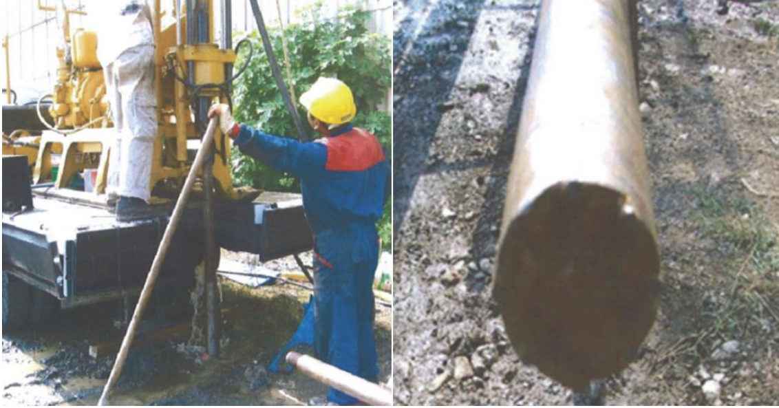
Şekil 9. Geoteknik rapor çalışmaları
