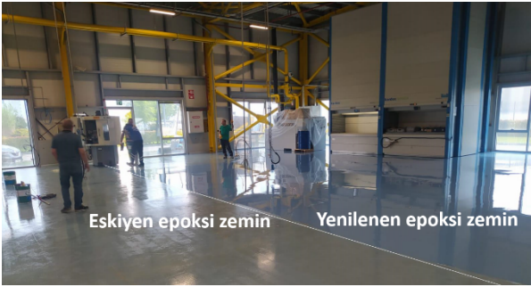
Şekil 8. Epoksi Zeminin Yenilenmesi
