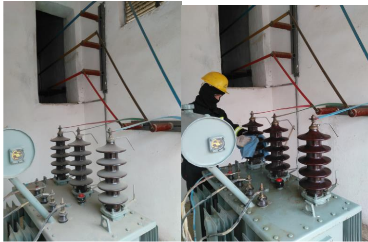
Şekil 14. Yüzeysel yalıtım ve koruma uygulaması
