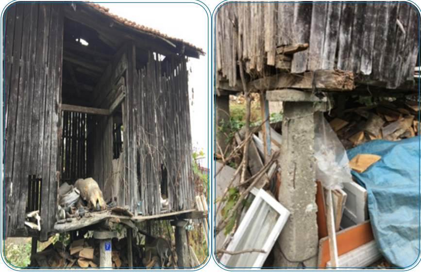
Resim 12: Evciler Mahallesi Kapalı Balkon Serenderi Ön Cephe ve Balkon
