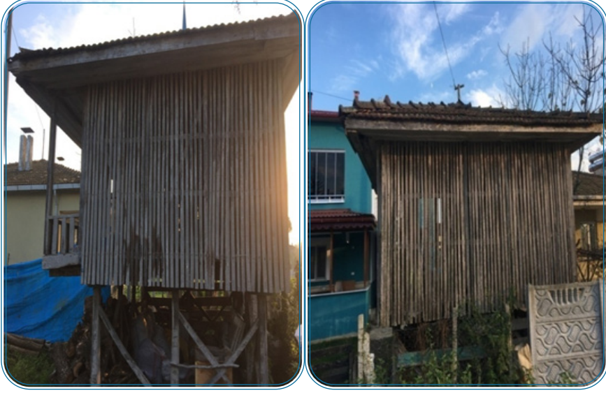
Resim 36: Elmaköy Mahallesi Serenderi Yan ve Arka Cephe
