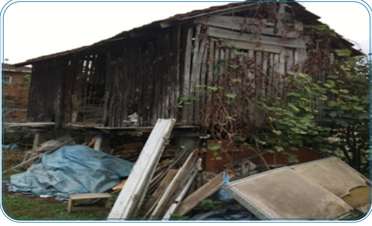
Resim 13: Evcı Mahallesi Kapalı Balkon Serenderi Yan Cephe
