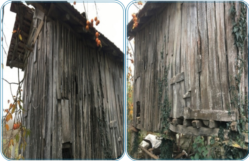
Resim 19: Evcı Mahallesi Eski Serenderi Yan Cephe
