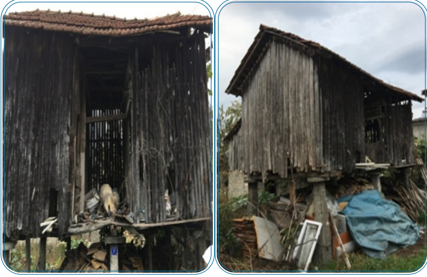
Resim 11: Evciler Mahallesi Kapalı Balkon Serenderi Ön ve Yan Cephe
