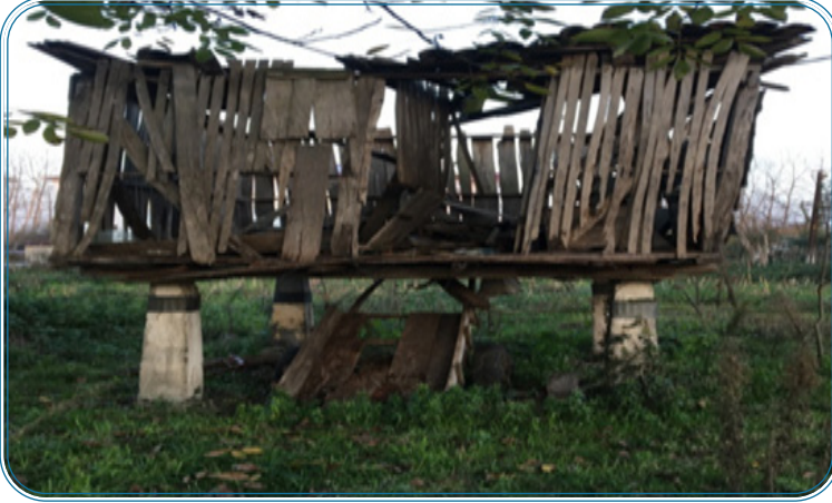
Resim 31: Yalı Mahallesi Serenderi Ön Cepheden Görünüm
