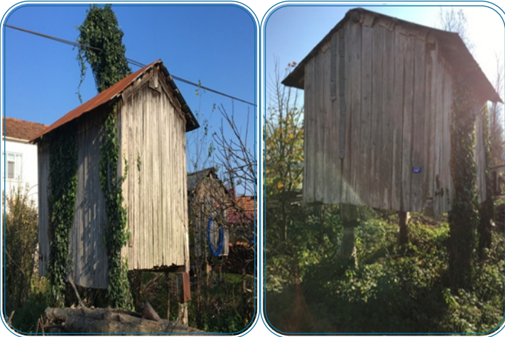
Resim 23: Sakarlı Mahallesi Serenderi Arka ve Yan Cephe
