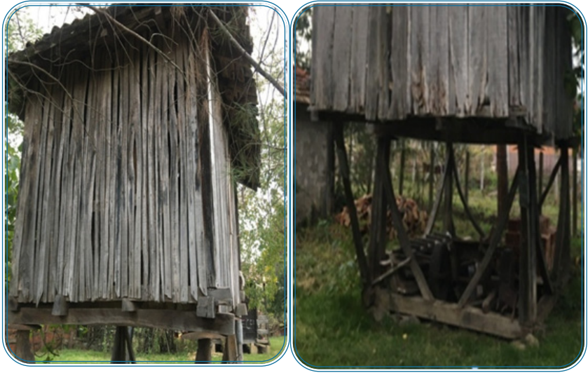
Resim 2: Mescitli Mahallesi En Eski Serenderi Arka Cephe ve Yan Cephe
