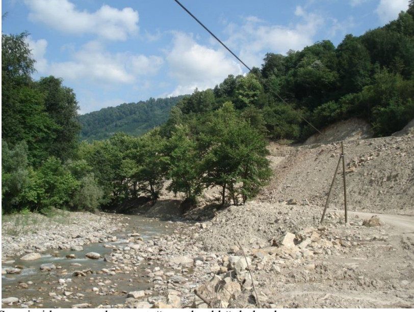
Şekil 3. HES projesi kapsamında su yatağının daraldığı bölümler
