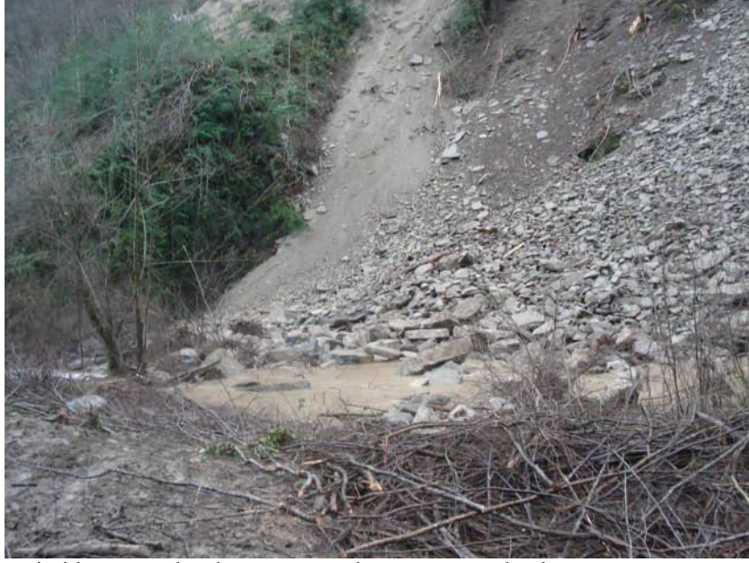
Şekil 5. HES projesi kapsamında çıkan toprağın akarsu yatağını daraltması
