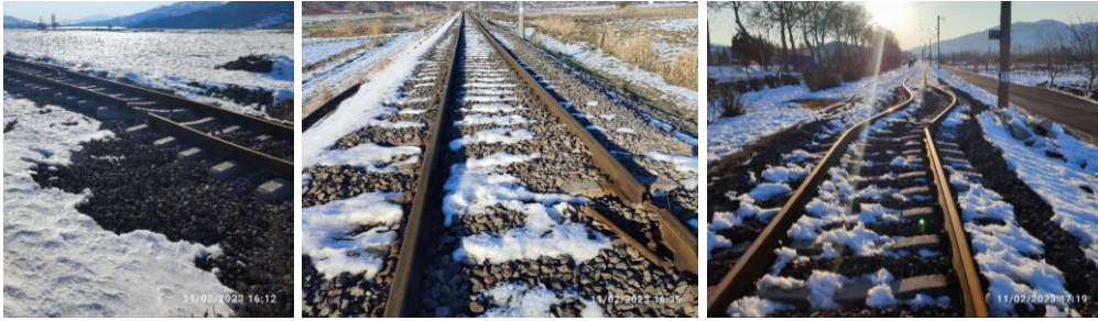
Şekil 5. Saha gözlemleri esnasında tespit edilen cebire bulunu ve ray kaynağı kırılmaları
