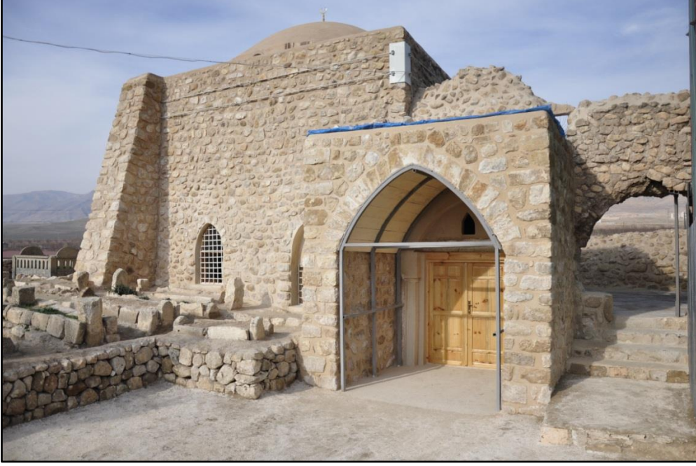
Resim 12: Türbe eyvan ve güney cephe uygulama sonrası.
