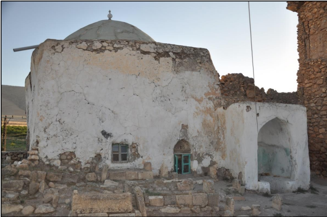
Resim 3: Türbe genel (güney cephe )
