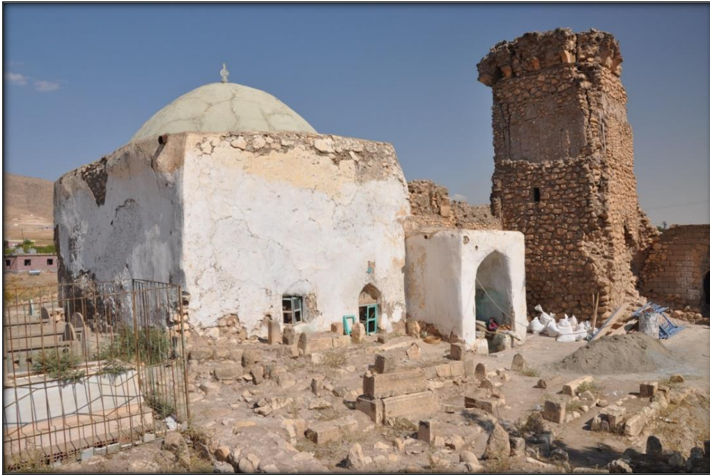
Resim 1: Genel görünüm (güneybatı cephe )
