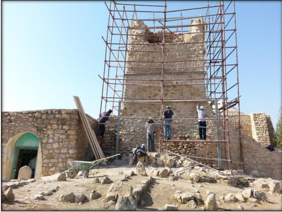
Resim 16: Kulede yapılan çalışmalar.
