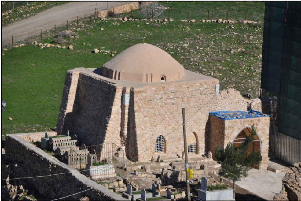
Resim 9: Türbe son hali (güneydoğu).
