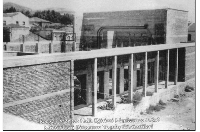
Resim 9. İzmit Halkevi Binasının Yapımı (Url-1).
