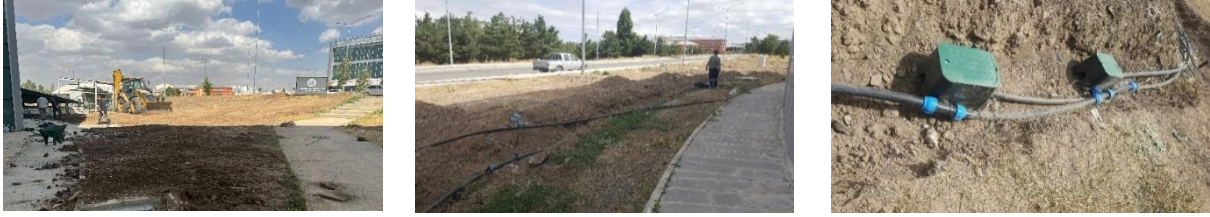
Şekil 4. Tesviye çalışmaları ve otomatik sulama tesisatı çalışmaları.
