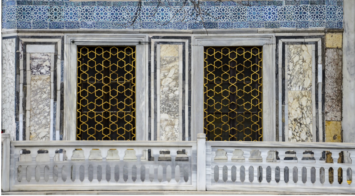
8 Bağdat Köşkü servis mekânının güney cephesindeki mermer kaplama düzeni
