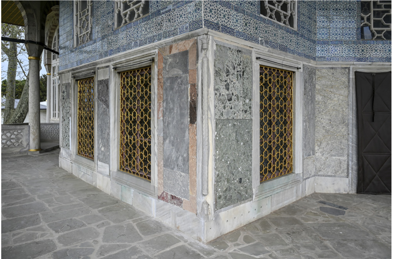
7 Bağdat Köşkü'nün kuzey ve kuzeydoğu cephelerinde görülen mermer kaplama düzeni
