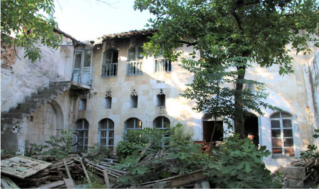
Görsel 22. Kuzey Kütlenin Avluya Bakan Cephesi
