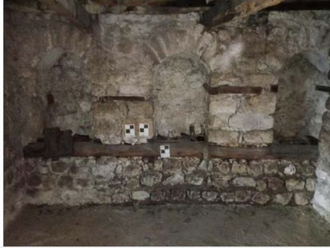
Görsel 9. Ahırın Doğu Duvarı
