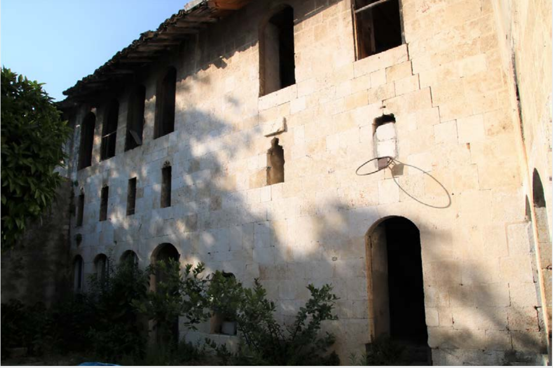
Görsel 23. Kuzey Kütlenin Avluya Bakan Cephesi
