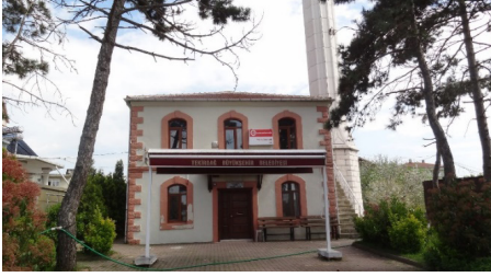
Fot.67: Yanıkađıl Köyü Camisi, giriş cephesi (Baçaru, 2023)
