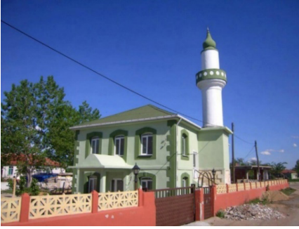
Fot.87: Naıbyusuf Köyü Camisi 164
