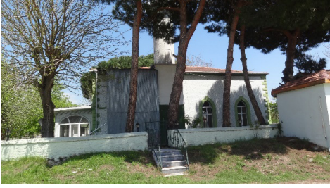
Fot.60: Uzunhacı Köyü Camisi, batı cephesi (Baçaru, 2023)
