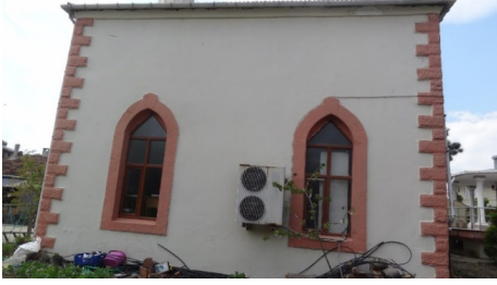
Fot.71: Yanıkağıl Köyü Camisi, güneydoğudan (Baçaru, 2023)
