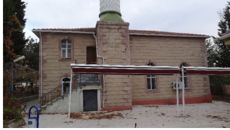
Fot.20: Şahpaz Köyü Camisi, batı cephesi (Baçaru, 2022)
