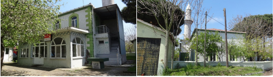
Fot.58: Uzunhacı Köyü Camisi, kuzeyden görünüş (Baçaru, 2023)
