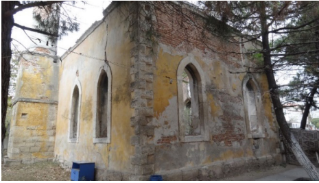
Fot.14: Karaağaç Köyü Camisi, güneyden kible ve batı duvarı (Baçaru, 2022)
