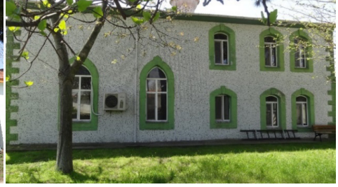
Fot.61: Uzunhacı Köyü Camisi, doğu cephesi (Baçaru, 2023)
