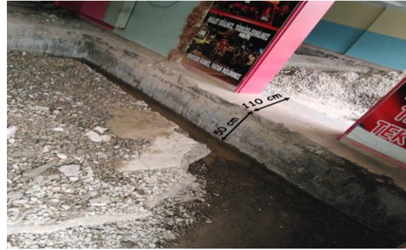
Şekil 9: İlkokulunun tespit edilen temel boyutları.
