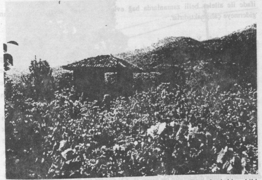
Fotoğraf 4. Aksaz köyündeki bir bağ evinin görünümü. Gayet basit bir şekilde inşa edilmiş bağ evinin, kapı ve penceresi bile bulunmamaktadır.
