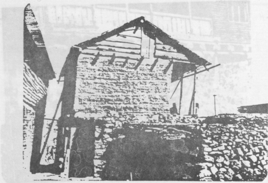
Fotoğraf 3. Dış cephesi çamur harcı ile sıvanmış bir konutun eklentileri ile birlikte görünüşü (Yolgözler köyü).
