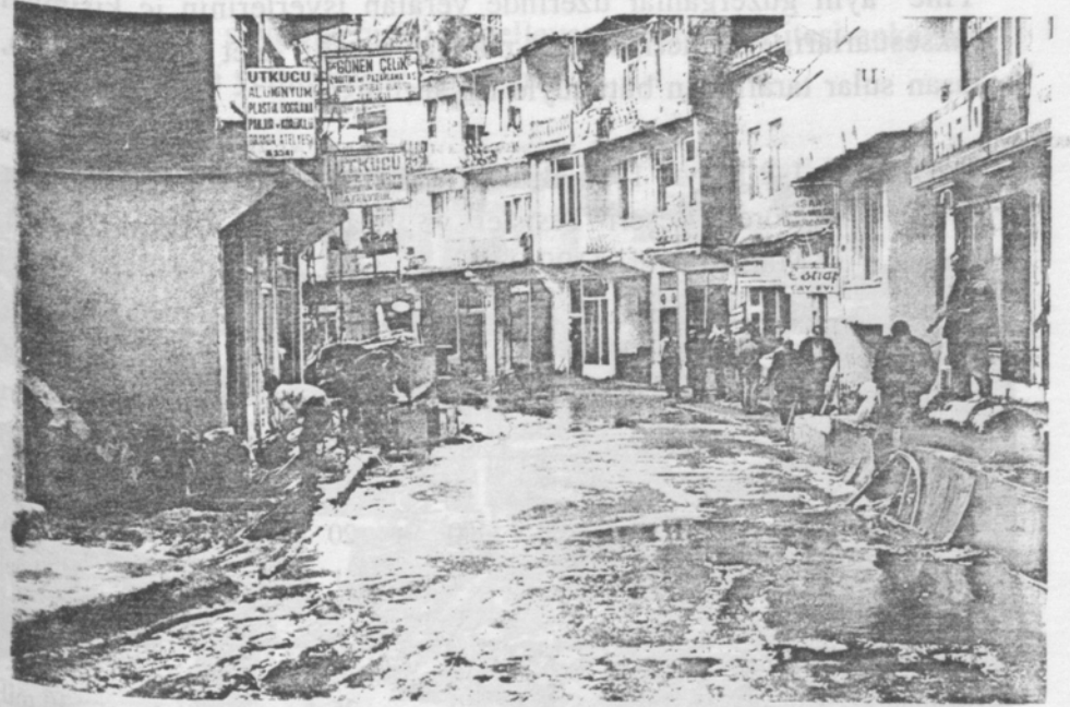
Fotoğraf 5: Arifbey Caddesi'nde hasar gören işyerlerinden bir görünüm.
