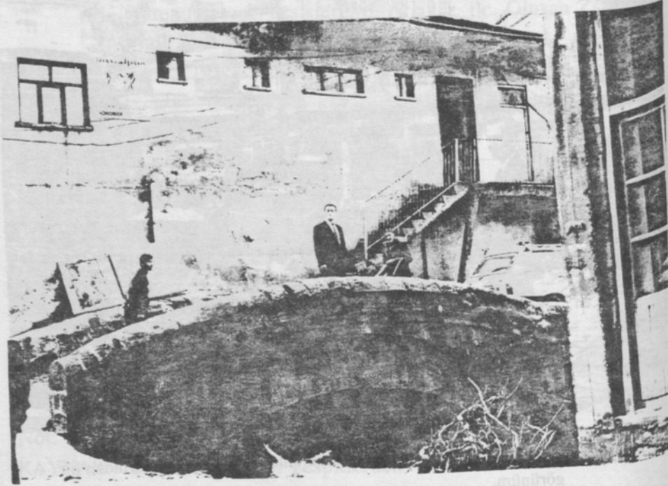
Fotoğraf 8: Kalealtı Caddesi'ndeki tarihî bir köprü ve yeni yapılan bir binadan görünüm (görüldüğü üzere akarsu tarafından taşınan ağaç kütükleri, tarihî köprünün altundan geçebilmiş, ancak sonra köprü seviyesinden daha alçak inşa edilmiş yeni bir binaya takılarak kalmıştır).
