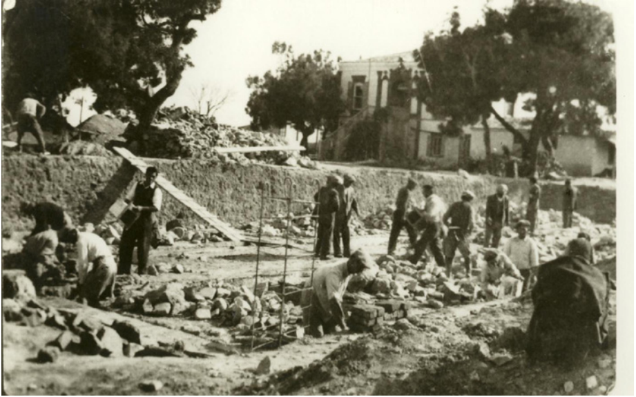
Resim 3-Akhisar Devlet Hastanesi'nin 1950-1954 yılları arasında inşaatı sırasında çekilen fotoğraf (Kaynak, Akhisar Belediyesi).
