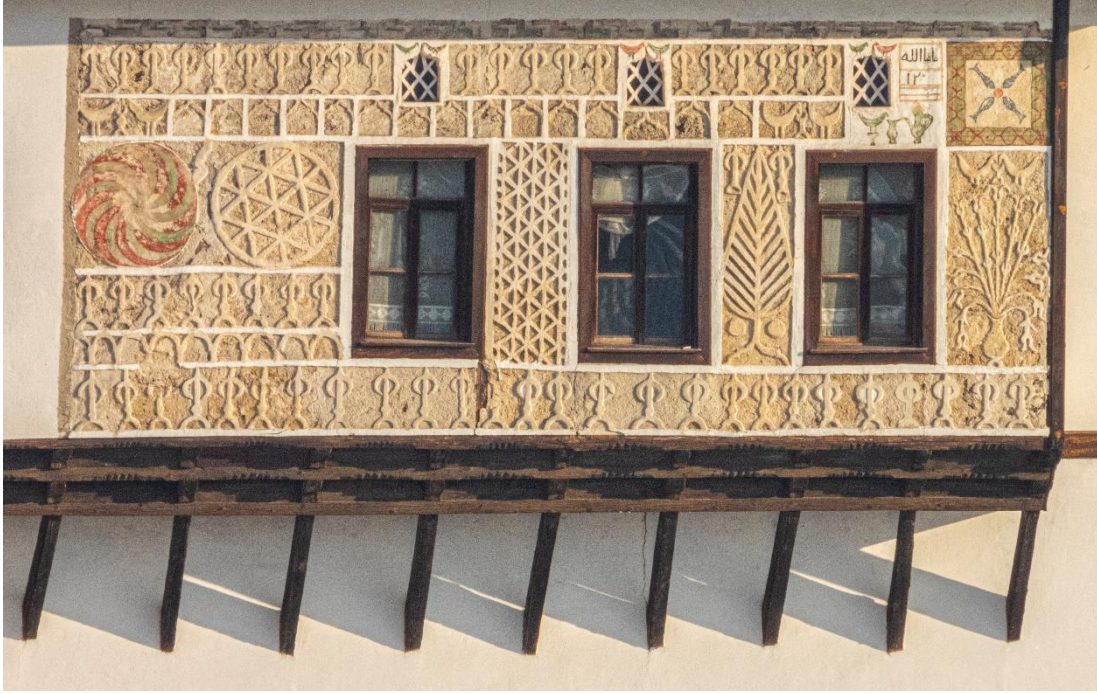
Görsel 15. Müderrisler evinin dış cephe görünümü.
