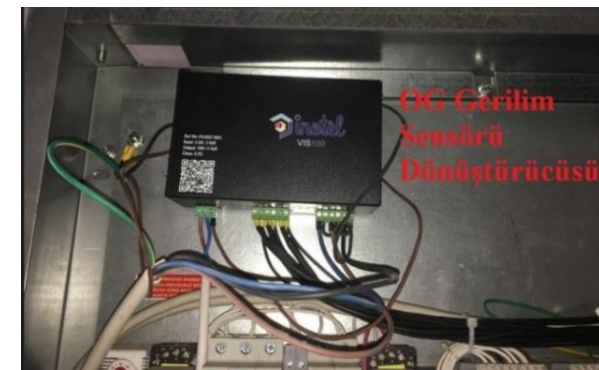
Şekil 10. OG tarafı gerilimlerinin ölçümü için kullanılan sensörlerin ve dönüştürücünün görüntüleri (Views of sensors and transducer used for measurement of MV side voltages)
