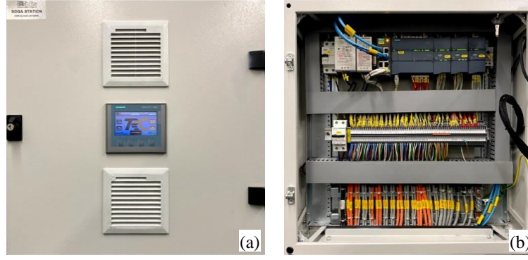
Şekil 8. Proje için üretilen (a) alarm kontrol ünitesi ve (b) iç görünüşü
