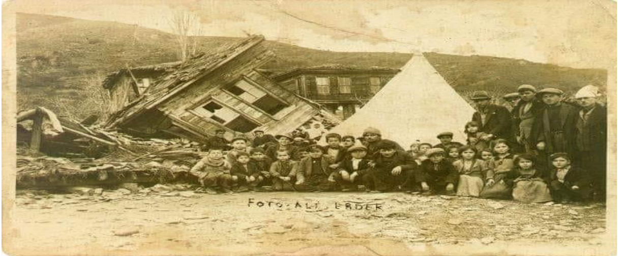
Fotoğraf 2 Depremde yıkılmış bir ev, çadır ve depremzedeler
