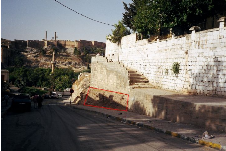
Fotoğraf 3: 1993 yılındaki yol genişletme çalışmaları sırasında bulunan Yeni mahalle Neolitik dönem yerleşmesinin yol kenarında kalan bölümü
