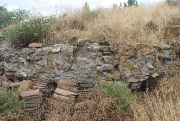
Foto.9: İzzet Paşa Camisi kalıntıları
