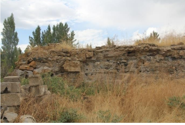
Foto.10: İzzet Paşa Camisi kalıntıları
