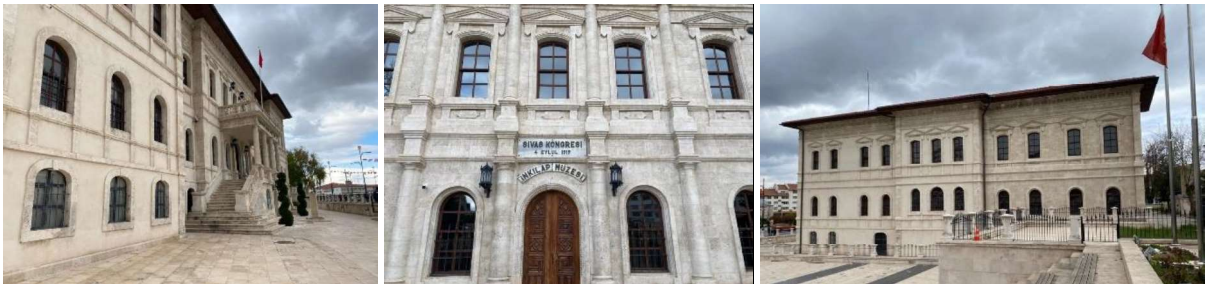
Görsel 6-7-8. Cephe Görselleri (Sırasıyla ön cephe; arka cephe; yan cephe).
