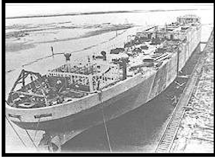
Şekil 4. Selma isimli beton gemi.
