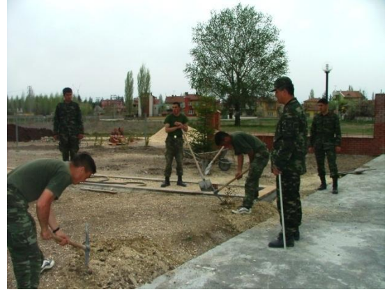
Resim 9. Askerlerden oluşan inşaat ekibi.
