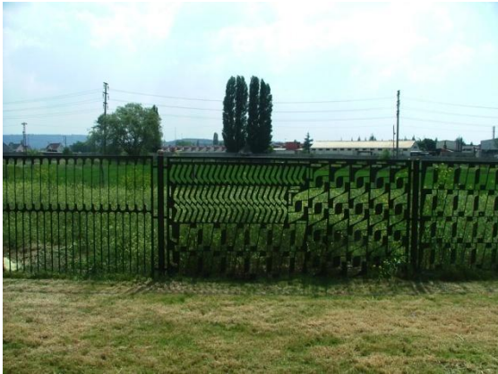
Resim 12. Atık demir panolardan oluşturulan düzenler sınır elemanları.
