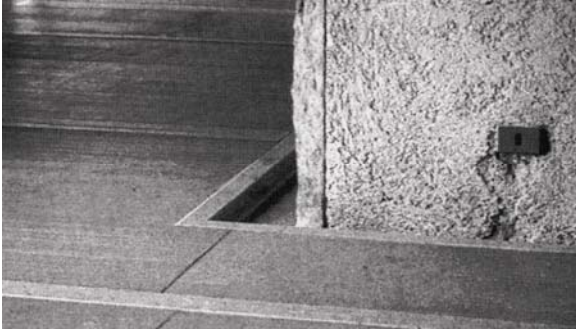
Resim 3. Castelvecchio Müzesi zemin kat duvarlarını kanallı çevreleyen döşeme kaplaması.
