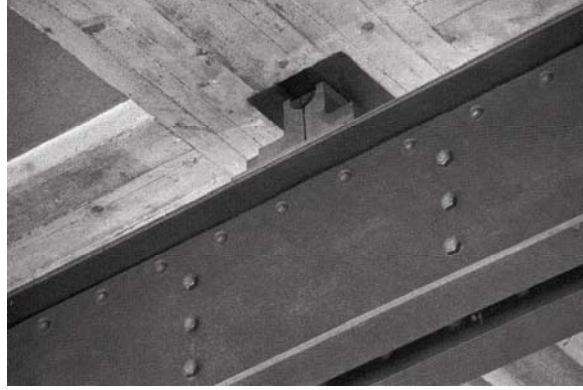
Resim 1. Castelveccchio Müzesi . Resim 2. Castelveccchio Müzesi zemin kat galerisi, beton ve çelik kirişlerin birleşim detayı.
