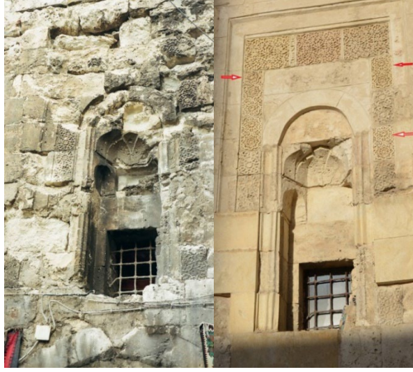
Fotoğraf 25: Ana eyvanın sağındaki pencerenin restorasyon öncesi ve sonrası durumu
