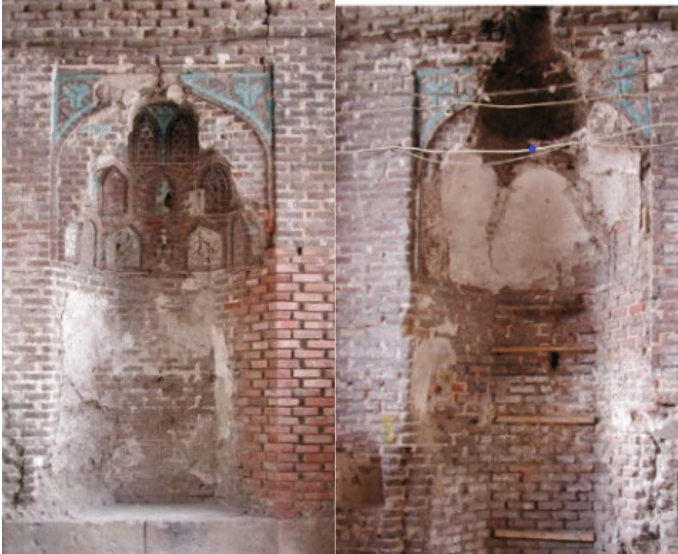
Fotoğraf 13: Kuzey eyvanda yan nişlerin onarım öncesi durumu (2005) (V.G.M. Arşivinden)
