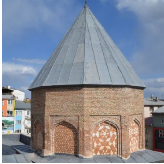
Fotoğraf 23: Türbe kasnağının onarım sonrası durumu 2017
