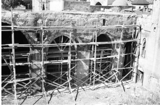
Fotoğraf 7: Darüşşifası kuzey revak cephesinde çürüyen taşların onarımı 1967-1969 (V.G.M. Arşivinden)
