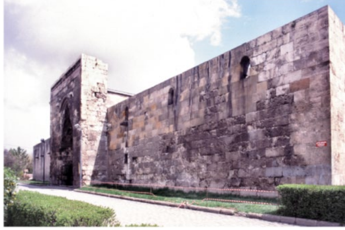
Fotoğraf 14: Darüşşifa giriş cephesi onarım öncesi durumu (2005) (V.G.M. Arşivinden)
