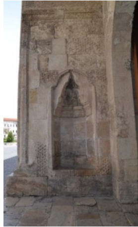
Fotoğraf 11: Taçkapı sağ yan nişi, onarım sonrası durumu
