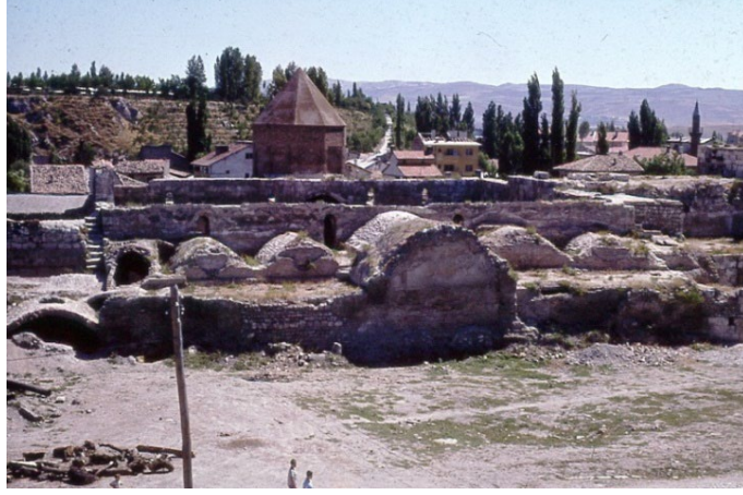
Fotoğraf 5: Darüşşifa kuzeyinde yer alan evlerin yıkılması ile açılan kuzey cephe (V.G.M. Arşivinden)
