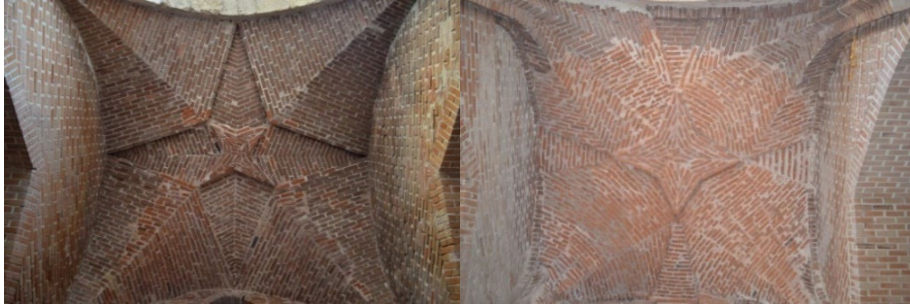
Fotoğraf 19: 23 ve 27 numaralı odaların önünde yer alan revak tonoz örtüsü onarım sonrası durumu
