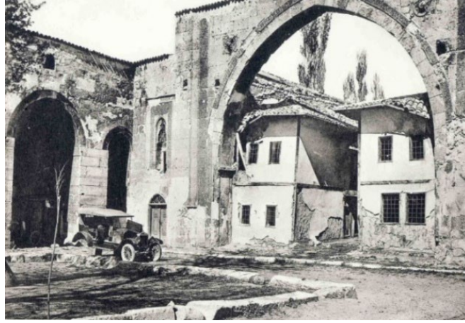
Fotoğraf 3: Üst örtüsü yıkılan ana eyvan ve sonradan yapılan kerpiç evler (A. Gabriel'den)
