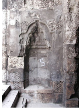
Fotoğraf 17: Taçkapı sağ yan nişi, onarım öncesi durumu (2005) (V.G.M. Arşivinden)
