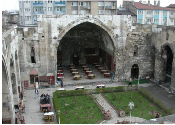
Fotoğraf 9: Ana eyvanın onarım öncesi durumu (2005) (V.G.M. Arşivinden)
