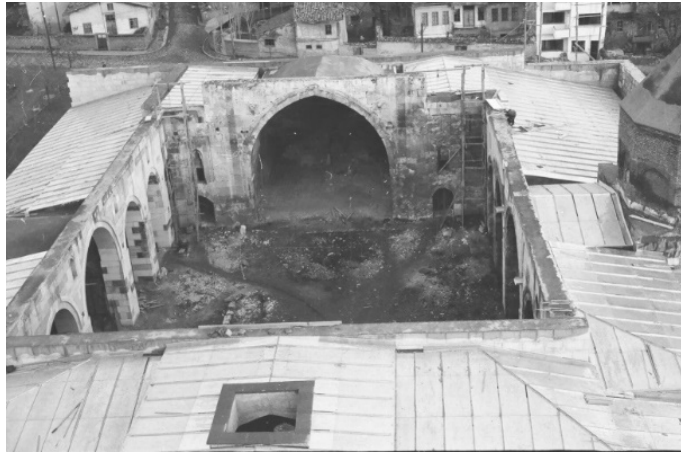
Fotoğraf 8: Onarımlarda yapılan sac kaplama üst örtü 1971 (V.G.M. Arşivinden)
