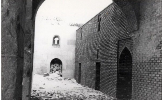
Fotoğraf 6: 1963 yılında duvarları tamamlanan güneydoğu hücreleri (V.G.M. Arşivinden)
