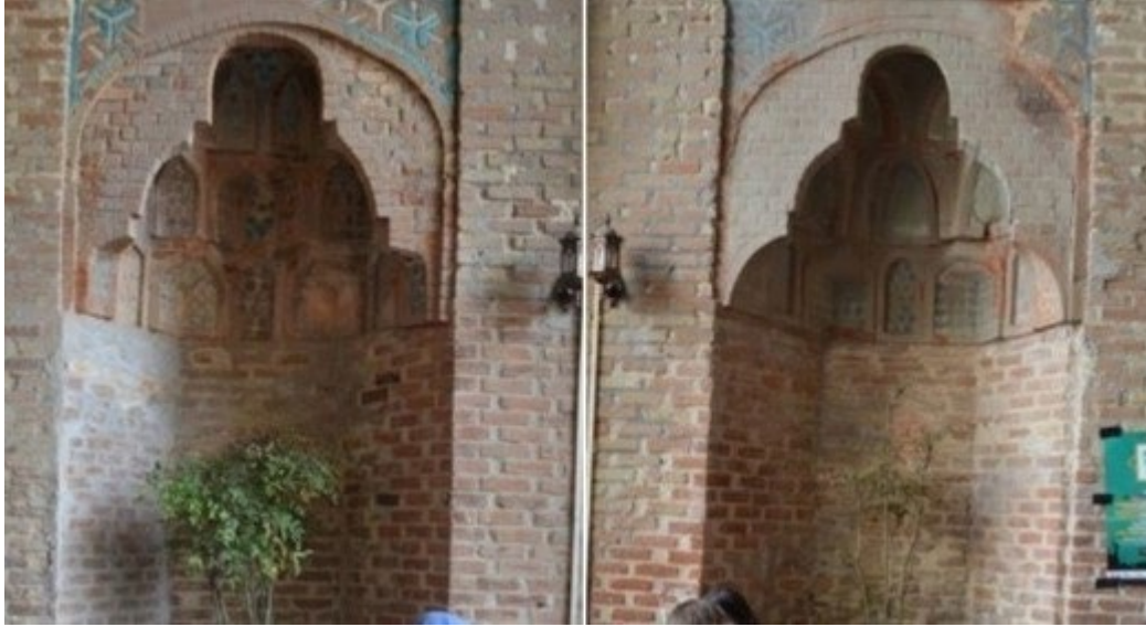
Fotoğraf 24: Kuzey eyvanda yan nişlerin onarım sonrası durumu (2017) (V.G.M. Arşivinden)
