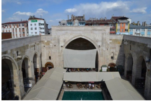
Fotoğraf 12: Ana eyvanın onarım öncesi sonrası durumu (2017) (V.G.M. Arşivinden)
