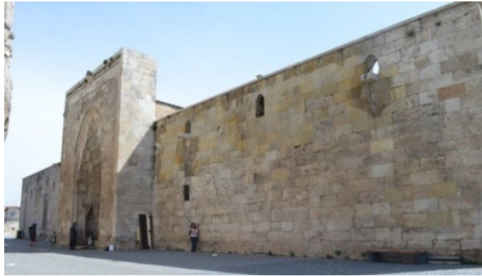
Fotoğraf 18: Darüşşifa giriş cephesi onarım sonrası durumu (V.G.M. Arşivinden)
