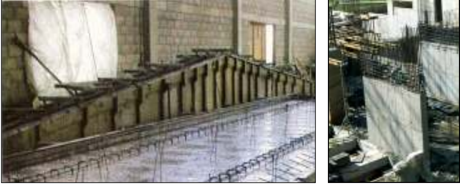
Şekil 10. KYB’nin prefabrikasyonda uygulanması.
