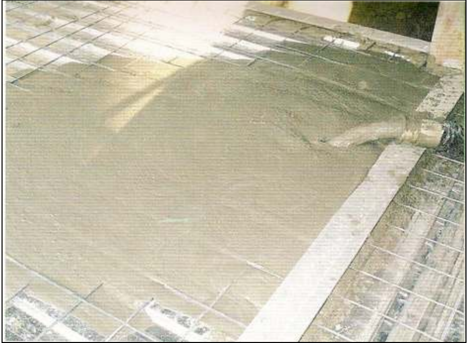
Şekil 1. Yüksek akıcılıkta kendiliğinden yerleşen beton.
