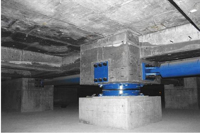
Şekil 1. Sismik izolasyon sisteminde ek sönümleyici kullanılması (Fotoğraf: Maurer Söhne)
