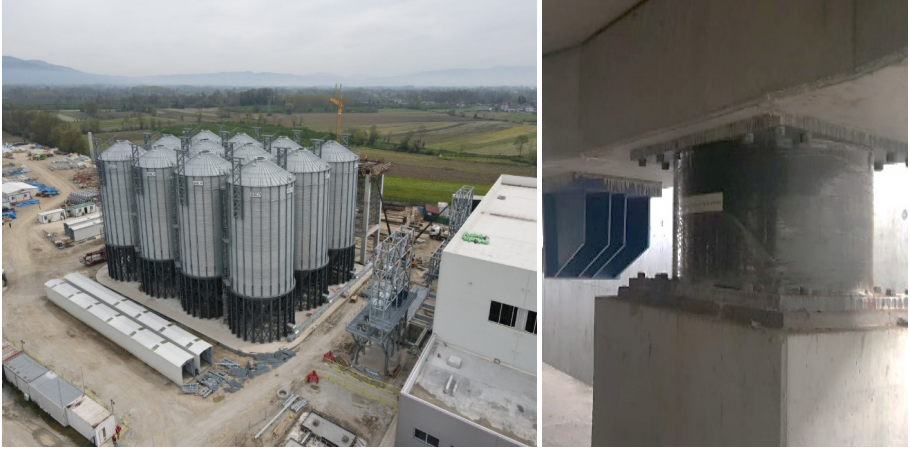
Şekil 6. Sismik izolasyonlu silo grubu yapısı ve kurşun çekirdekli kauçuk izolatör. Ferrero Fındık Üretim Tesisleri, Düzce, Çilimli (Fotoğraf: Gahafari Associates LLC)
