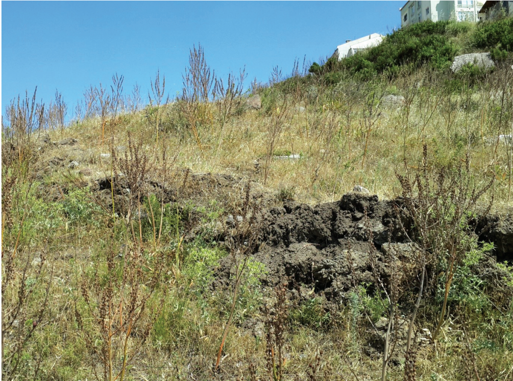
Şekil 17. Heyelanın topuk bölgesinde meydana gelen deformasyonlar (kuzeybatıdan güneydoğuya doğru fotoğraf çekimi yapılmıştır).
