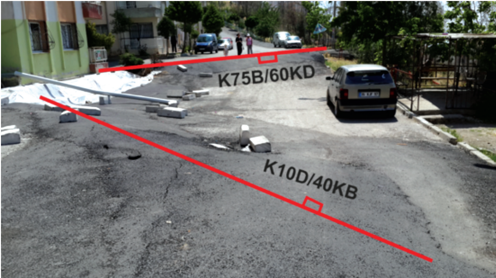
Şekil 3. Çınar apartmanının kuzey cephesinde heyelan nedeniyle oluşan deplasmanlar.
