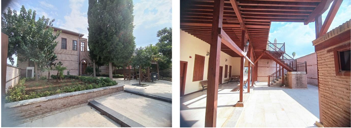
Şekil 3. Yapının batı (giriş) cephesinden ve iç avludan görünüşü.
