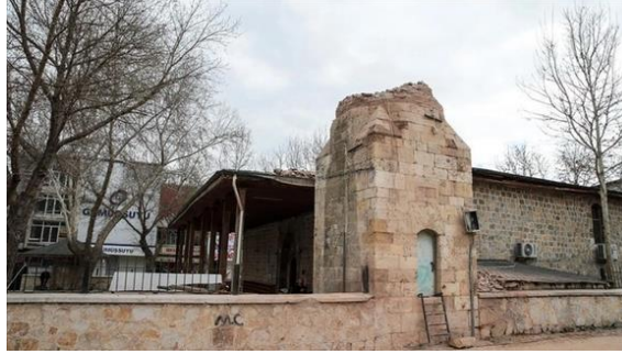
Şekil 11. Küp (Pabuç) bölümünden hasara uğramış minare, Kahramanmaraş 2023 (Elbistan'daki tarihi Atik Camisi'nin minaresi, 2023)
