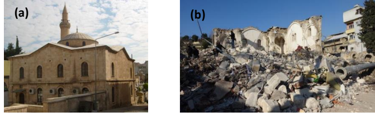
Şekil 27. (a) Adiyaman Ulu Camii deprem öncesi (Adiyaman İl Kültür ve Turizm Müdürlüğü, 2019), (b) Adiyaman Ulu Camii deprem sonrası (Dulkadiroğulları tarafından yapılmıştı, 2023)
