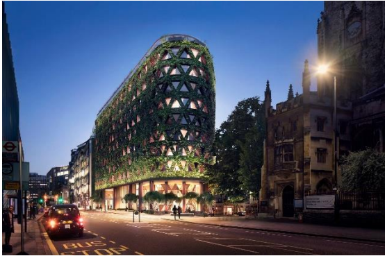
Şekil-13. Citicape House cephesinin genel görünümü (Robson, b.t.)
