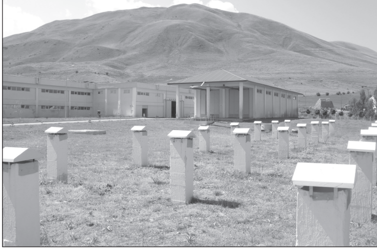
Fotoğraf 8: Erzurum Su Arıtma Tesislerinden Genel Bir Görünüm.
