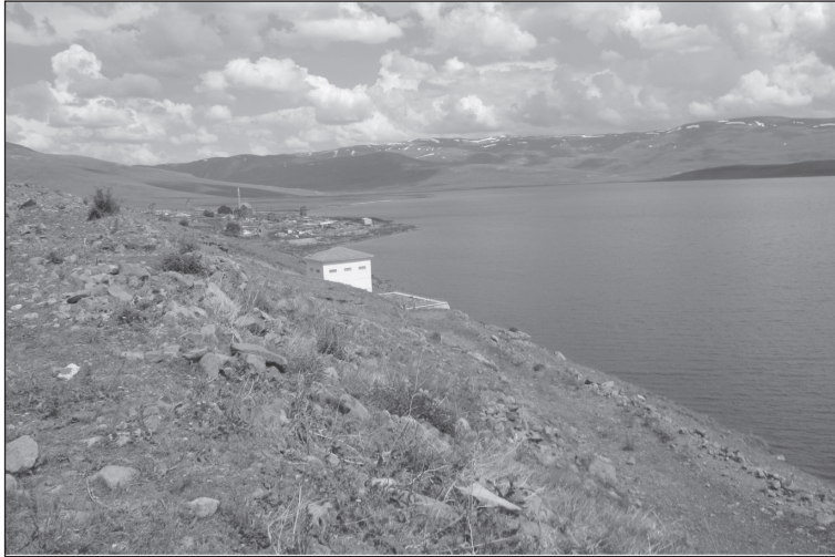
Fotoğraf 3: Taşağıl Köyü ve Palandöken Barajından Suyun Tünel Giriş Yerinden Görünüm
